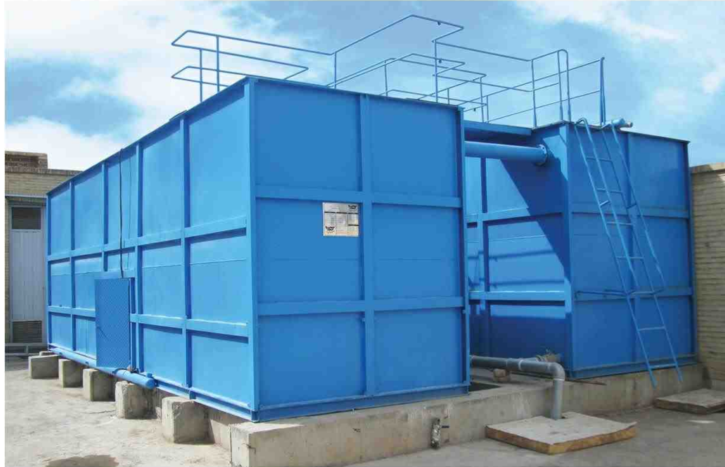
حزمة تنقية مياه الصرف الصحي بطاقة 80 متر مكعب في اليوم
